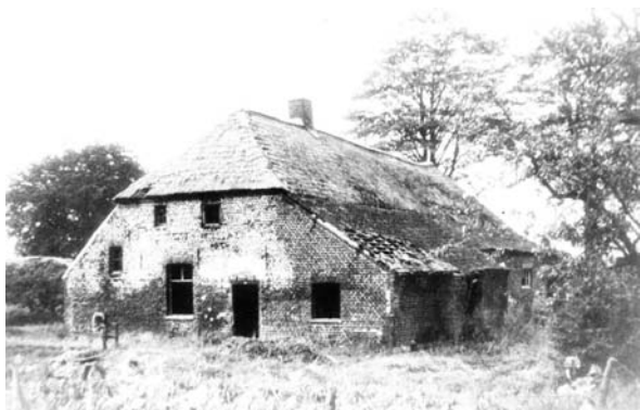
Afb. 3 Ongedateerde foto van de boerderij Oude Berkt. (Bron: Van Dijk 2005).
