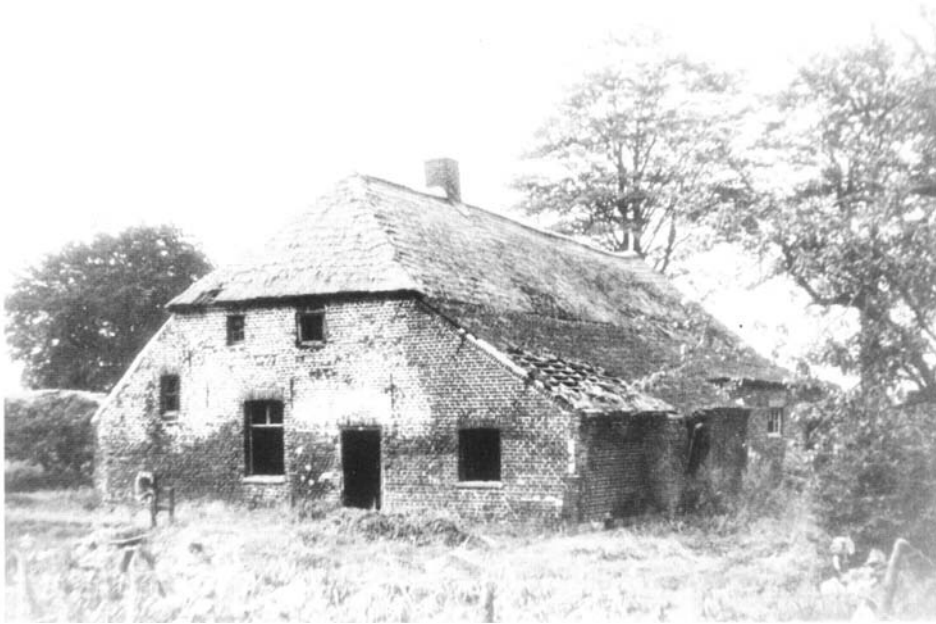
Afb. 3.2 Ongedateerde foto van de boerderij Oude Berkt. (Bron: Van Dijk 2005).
